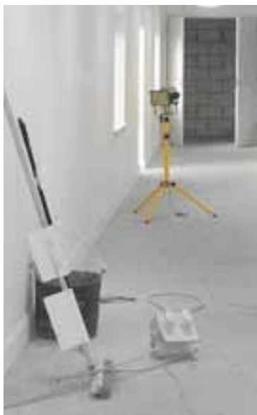
Stojany pro svítidla typu MCOB
