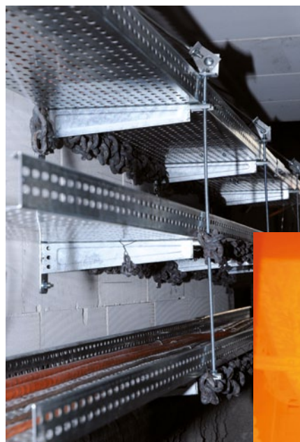
Pohled do zkušební komory
