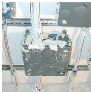
Skříň s připojenými kabely po testu.
