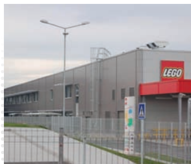
► Výrobní hala Lego, Kladno přístroje Mosaic, parapetní kanály DLP
