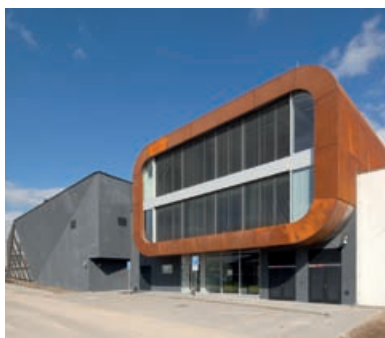
► Datové centrum Lužice systém strukturované kabeláže LCS 2 , parapetní kanály DLP, přístroje Mosaic
