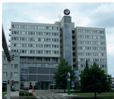
► Administrativní budova Škoda Auto, Mladá Boleslav parapetní kanály DLP, podlahové krabice, přístroje Mosaic
