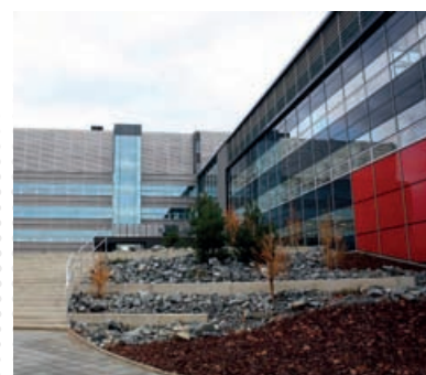
► Lékařská fakulta UP, Olomouc systém strukturované kabeláže LCS 2 , parapetní kanály DLP, přístroje Mosaic a Valena, jištění a spínání
